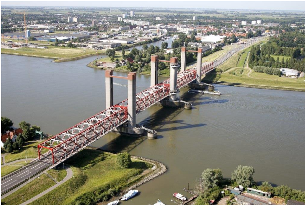
Figuur 2-1: Spijkenisserbrug (bron: wegenwiki.nl)
