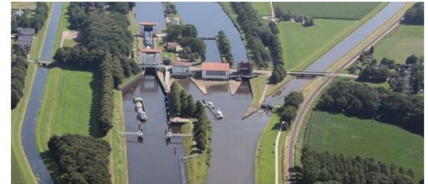
Sluis Eefde [Rijkswaterstaat]
