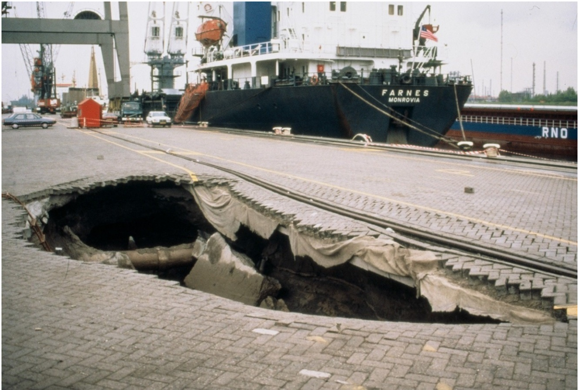
Figuur 2.24 Rotterdamse haven, gevolg van uitspoeling t.g.v. uit het slot gelopen damwand [van Weele]
