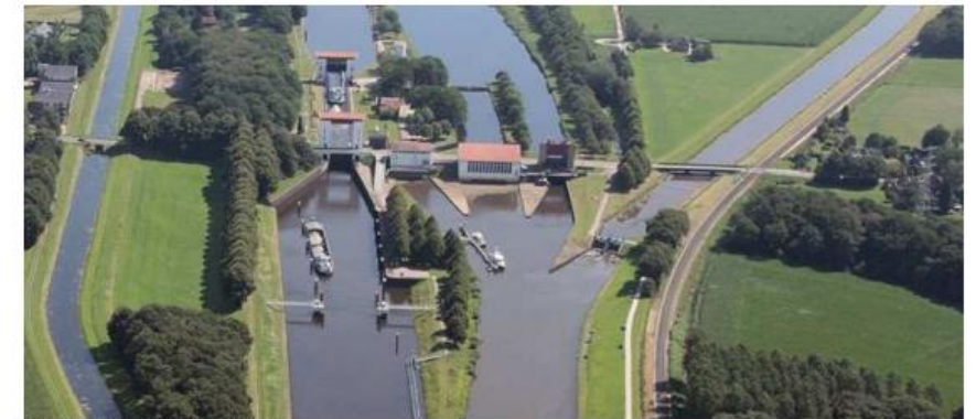
Sluis Eefde [Rijkswaterstaat]
