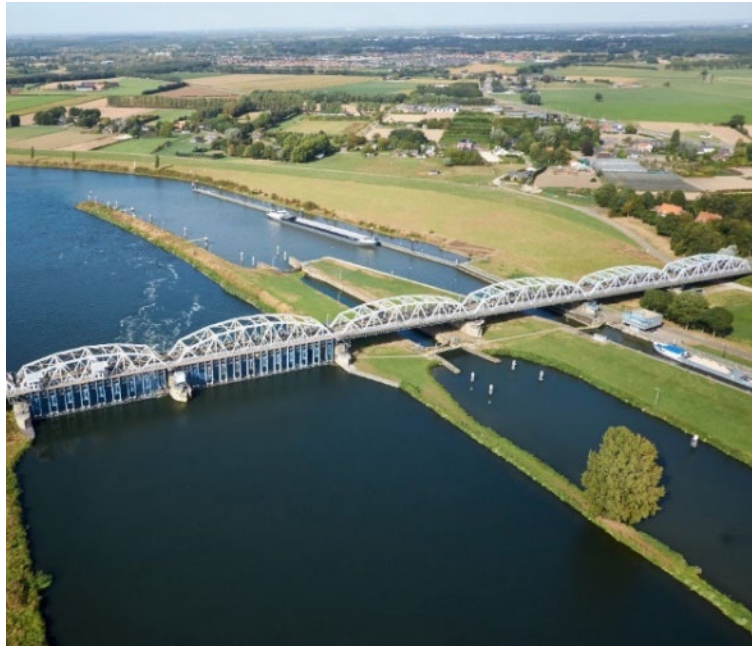
Figuur 3: Stuwcomplex Grave met rechts de enige sluiskolk in operatie
