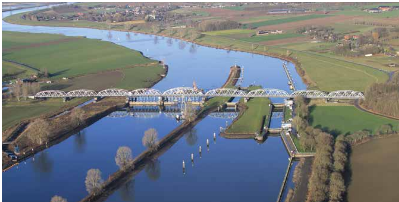
Stuw- en sluisencomplex in de Maas bij Grave
