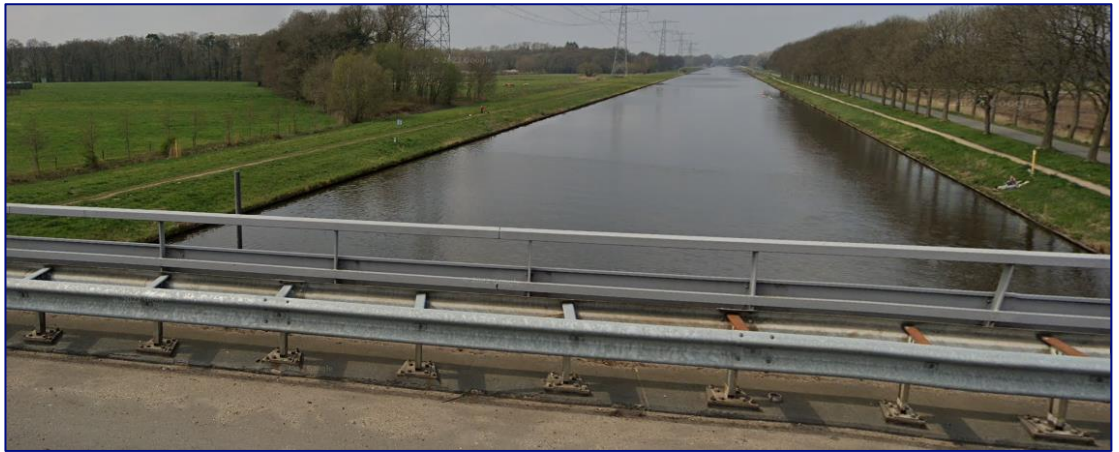
Figuur 71 Aanzicht damwandconstructie naast Loofrietbrug [bron Google Maps].
