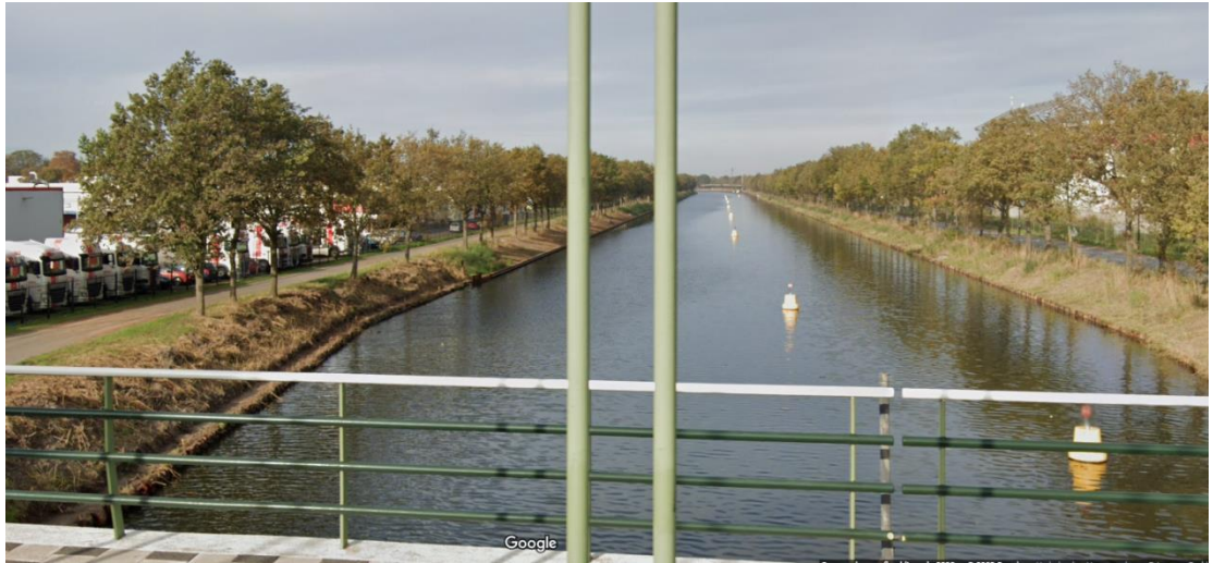
Figuur 56 Aanzicht noordwest oever aan de westzijde van de Lonnekerbrug.
