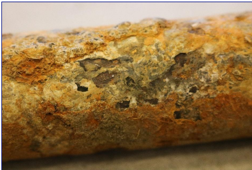
Figuur 47 Corrosie product detail locatie Anna.
