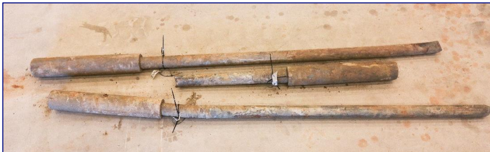
Figuur 53 Corrosie product ankers locatie CTW.
