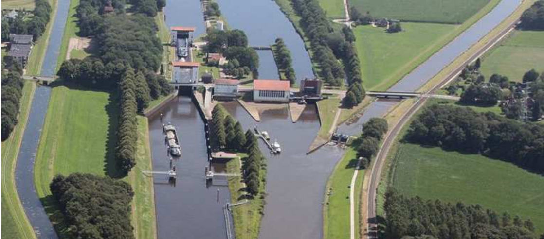
Sluis Eefde [Rijkswaterstaat]
